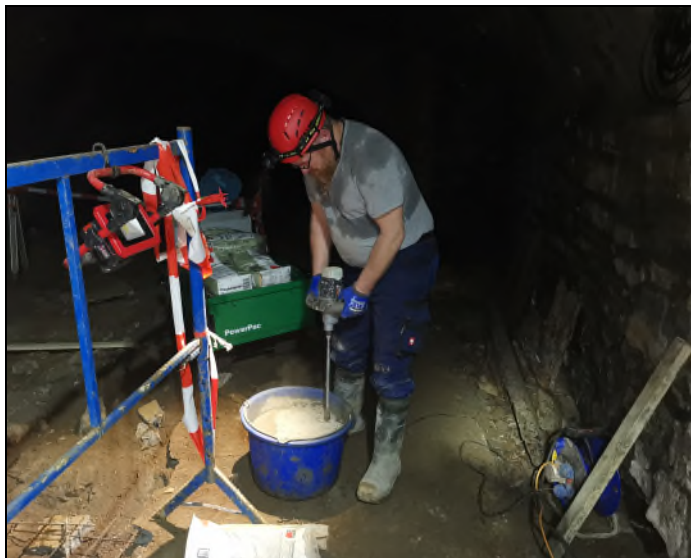
Reparatur schadhafter Stellen am Weidtmanschacht und betonieren der Brücken-Auflager. Christoph rührt hier eifrig den Fertigbeton an.
