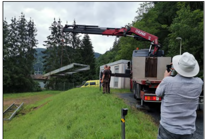
Abholen der Stahlbrücken an der Kläranlage Bad Ems. Thorsten Gökpınar (rechts) verfolgt das Geschehen.
