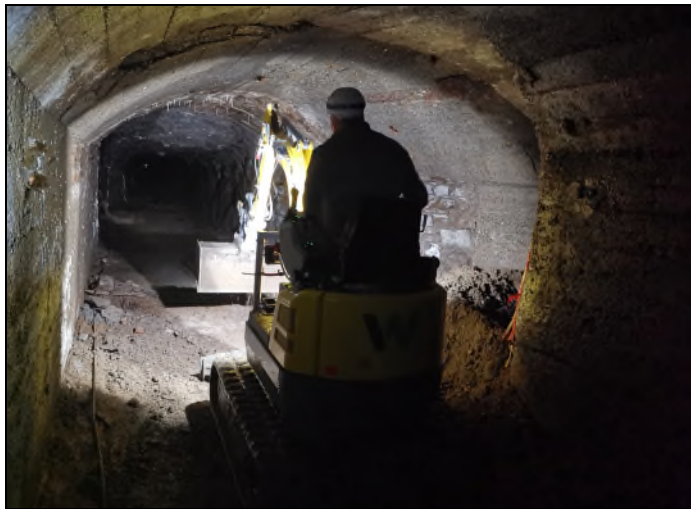
Planieren der Stollensohle mit einem Elektrobagger, der von Thomas Emmerich beschafft und bedient wurde.
