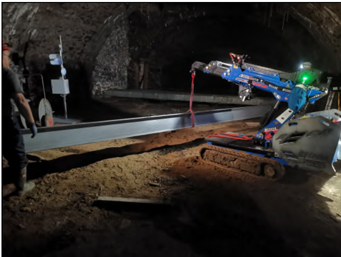
Montage der Brücken und Stahlträger mit Akku-Mietkran.
