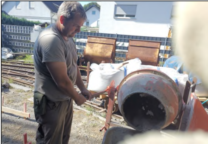
Thomas Emmerich in der „Betonküche“.
