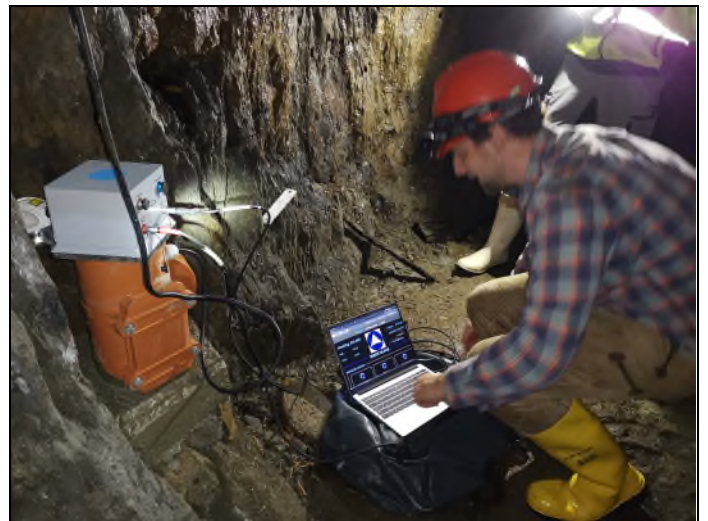
Tief im Stollen: Das Seismometer „spricht“! Kontrolle der installierten Komponenten per Notebook. Fotos: Girmann
