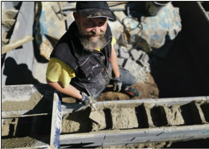
Bodo Hinterwäller verteilt den Beton in die Schalsteine.
