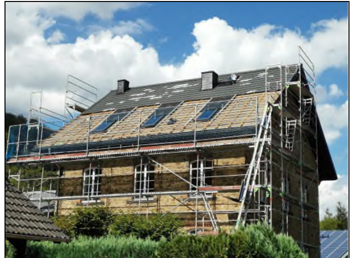
Was wäre das Steigerhaus ohne ein Baugerüst? Schadensbehebung nach „Fleckfieber“. Foto: Girmann
