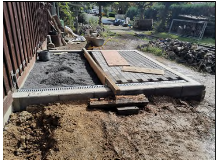
Pflasterarbeiten bilden vorerst den Abschluss dieses wichtigen Bauabschnitts für unser Museum. Fotos: Frank Girmann
