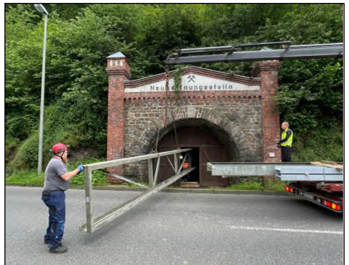
Millimeterarbeit war die Einfädelung der schweren Brückenteile in den Stollen. Transporteur Dehe aus Lahnstein und Christoph Specht finden souverän das „Nadelöhr“.
