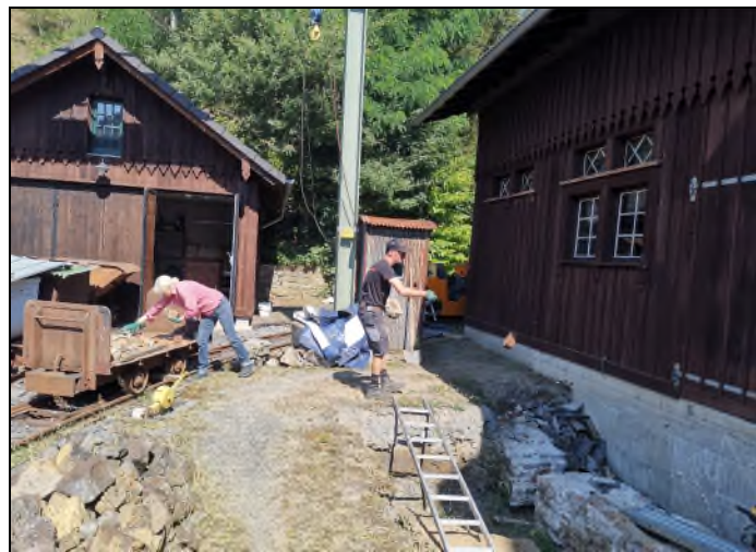
Die alte Kellertreppe wird verfüllt.
