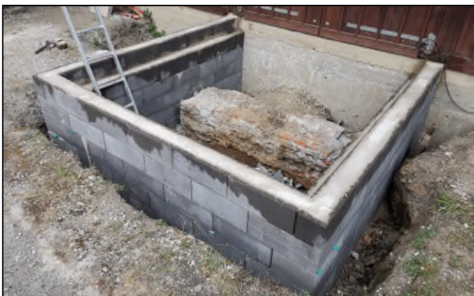
Der fertige „Rahmen“ wartet auf seine Verfüllung.
