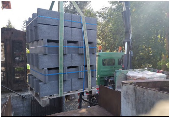
Anlieferung des Baumaterials.
