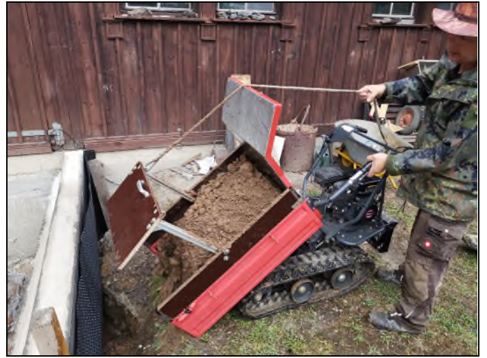
Mittels Dumper wird Verfüllmaterial herangekarrt.
