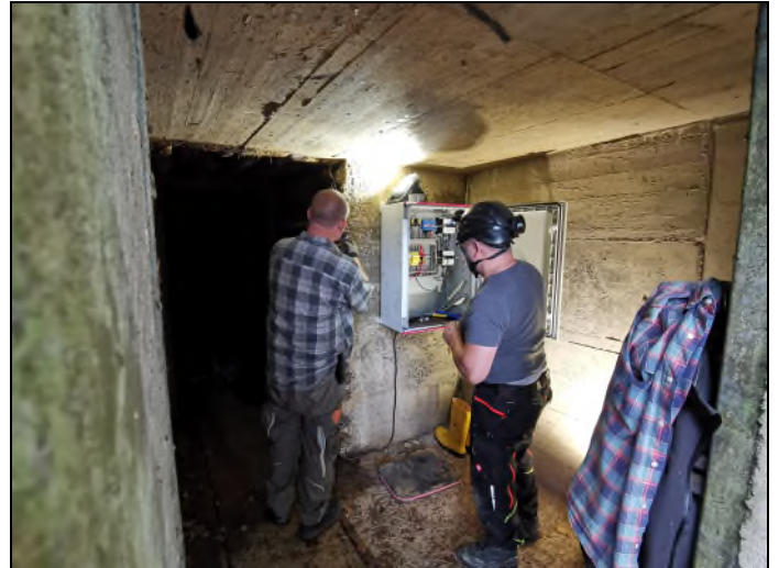
Montagearbeiten am Technikschränk im Eingangsbaubereich des Stollens Wolfstaller Rösche.
