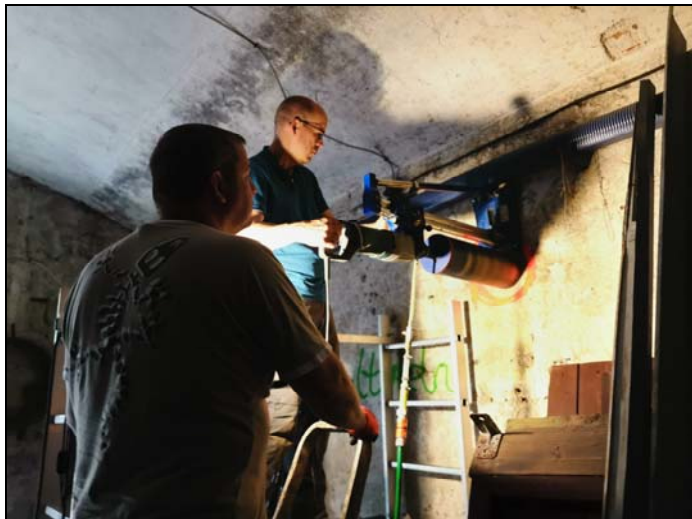
Der Kernbohrer frisst sich durch 90cm Bruchstein. Fotos: FG
