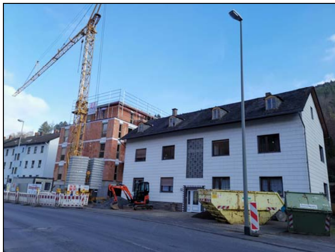
Der erste Bauabschnitt lugt hinter dem alten Zechenhaus der Grube Fahnenberg hervor. Fur den zweiten geplanten Wohnblock muss das historische Gebaude voraussichtlich im Sommer 2023 weichen. Foto: Girmann
