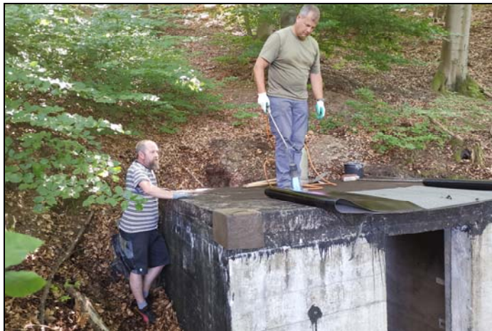
Thomas Emmerich und Bodo Hinterwaller braten der Wolfstaller Rosche „eins aufs Dach“. Derweil bearbeitet Frank Girmann unsichtbar die Eisentur mit Drahtburste und Farbe. Der Erdbebenmesser aus Potsdam kann kommen! Foto: FG
