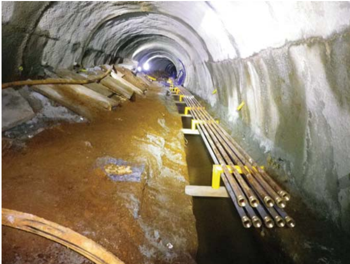
Wärmetauscher-Rohrbündel mit Kupferrohren vor dem Einbau in die Rösche des Stadtstollens, der in diesem Bereich schon August 1990 mit Spritzbeton saniert wurde. Foto: Girmann
