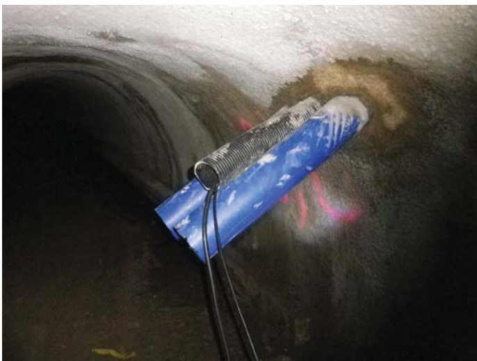
Im vorderen Stollenbereich wurde das Gewölbe für Wärme- und Datenleitungen aus dem Bereich Ludwigstraße angebohrt. Die Leitungen verlaufen vom Bohransatz durch die Bleichstraße in Richtung des Rathauses der Verbandsgemeindeverwaltung Bad Ems zur dort installierten Wärmepumpe. Foto: Girmann
