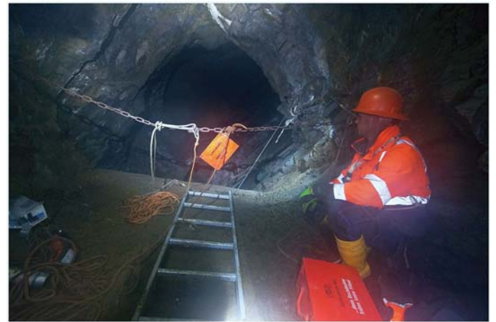
Bestandteil der Anlage im Stadtstollen ist auch ein geforderter rückwärtiger Fluchtweg über das Wetterüberhauen in den Neuhoftungsstollen. Hierfür wurden im rund 15 Meter tiefen Gesenk von einem Fachunternehmen Fahrten eingebaut sowie in den Stollen Fluchtschilder angebracht. Foto: Girmann
