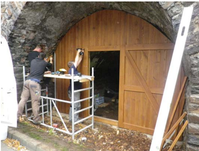
Fast fertig: die Wagner-Leute bei der Arbeit.
