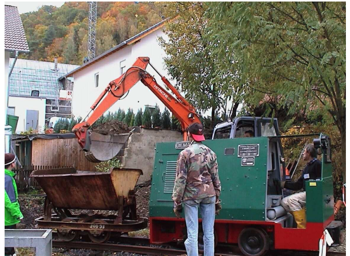
Mit dem Bagger wurde das Lokschuppenfundament ausgehoben und von Lok und Lore das Verfüllmaterial an die Betonmauern des Eingangsbereich gefahren. Foto: Winkler
